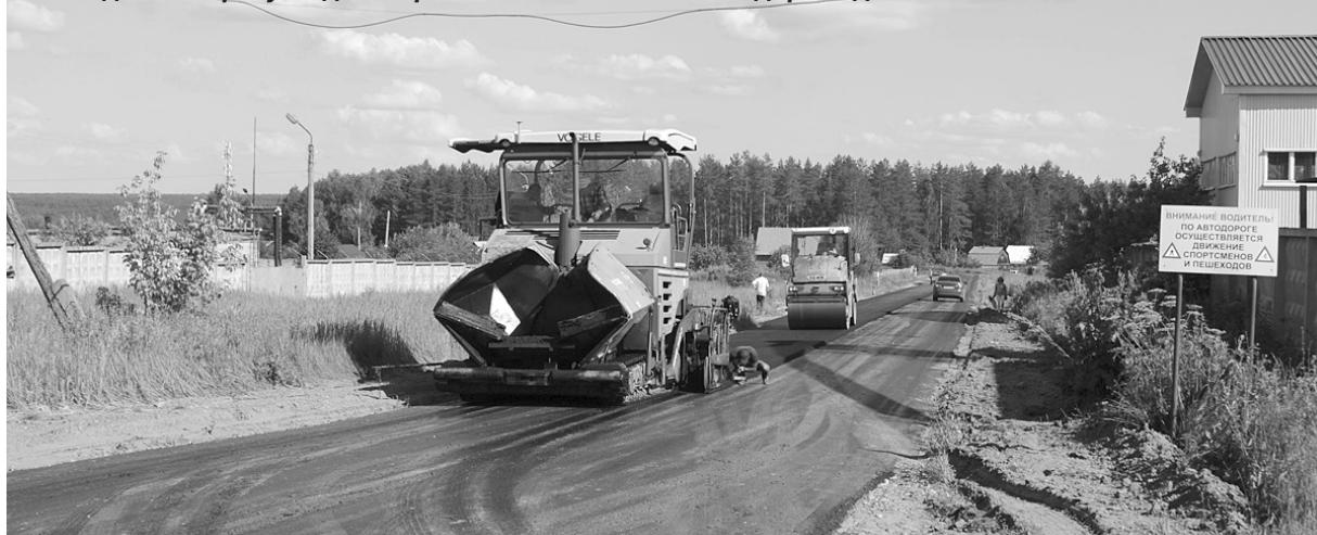
Последние метры укладки асфальта на автомобильной дороге до лыжно-биатлонного комплекса.
